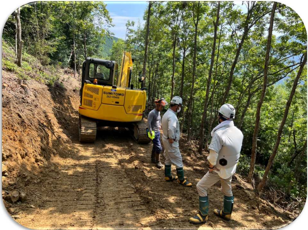
進捗、作業手順等の確認
