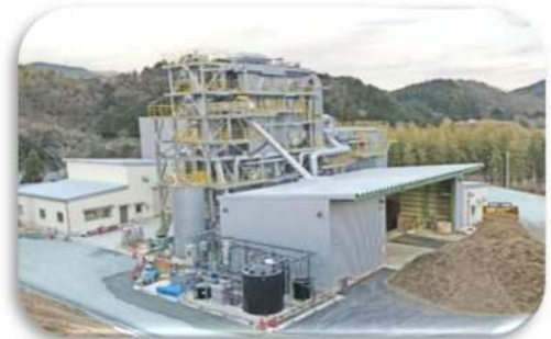
バイオマス発電所
